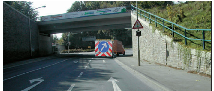
7 Nach der Unterführung der abknickenden Straße folgen
